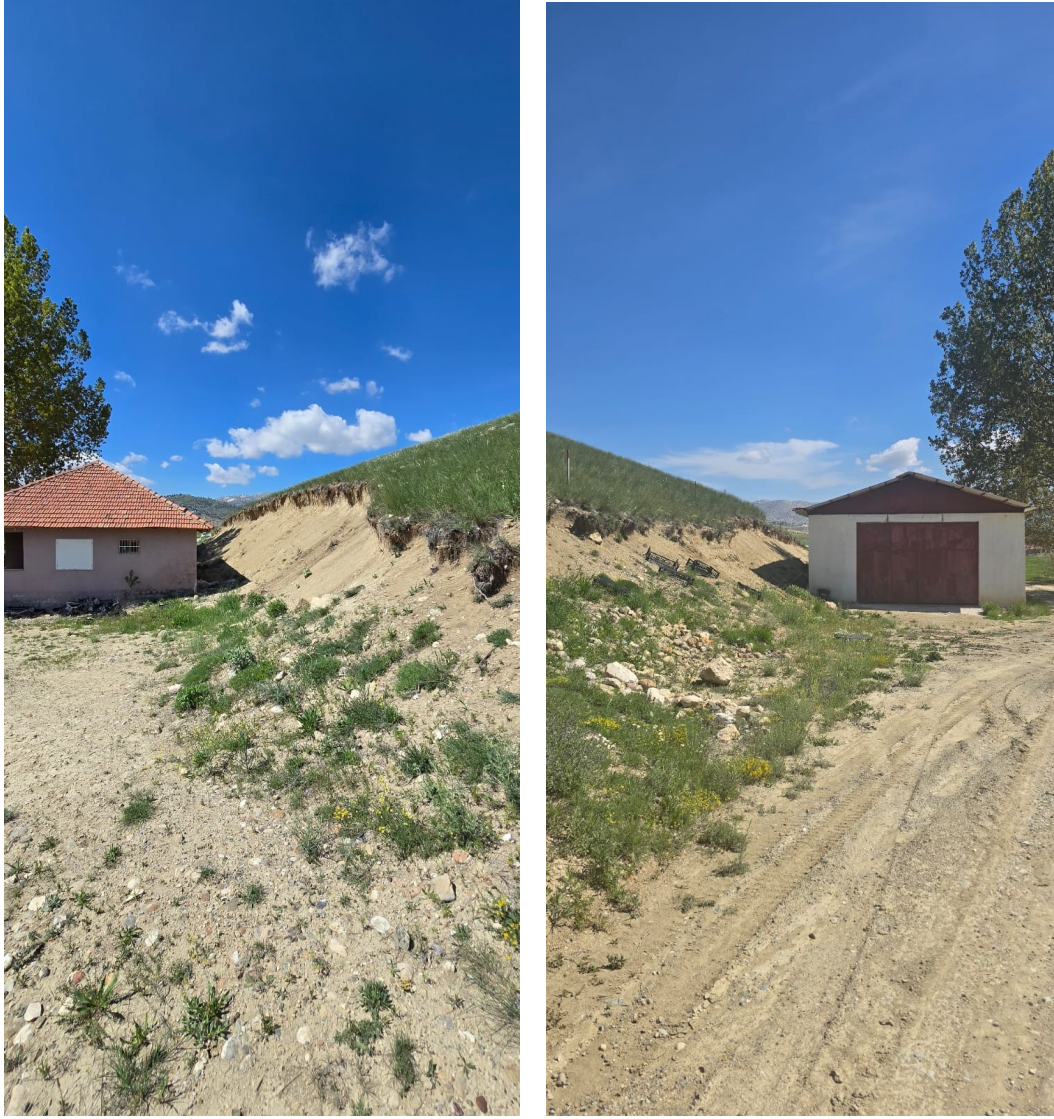
Şekil 11. İstinat duvarının inşa edileceği alan
